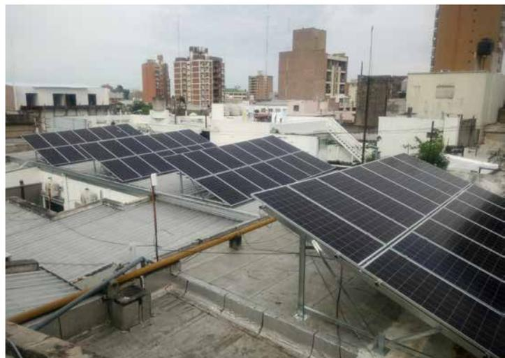
tica autosustentable mediante la colocación de paneles solares fotovoltaicos que posibilitan la inyección de energía sobrante a través de un sistema inversor de control energético. El excedente energético será entregado a la distribuidora ENERSA, empresa que compensará el mismo en las facturaciones futuras del Instituto.\*
